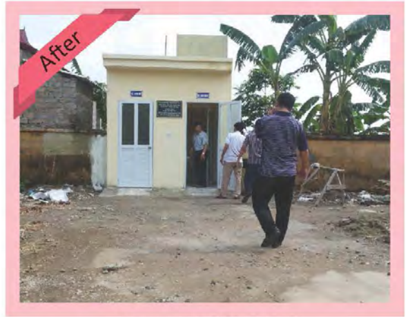
New accessible toilet
